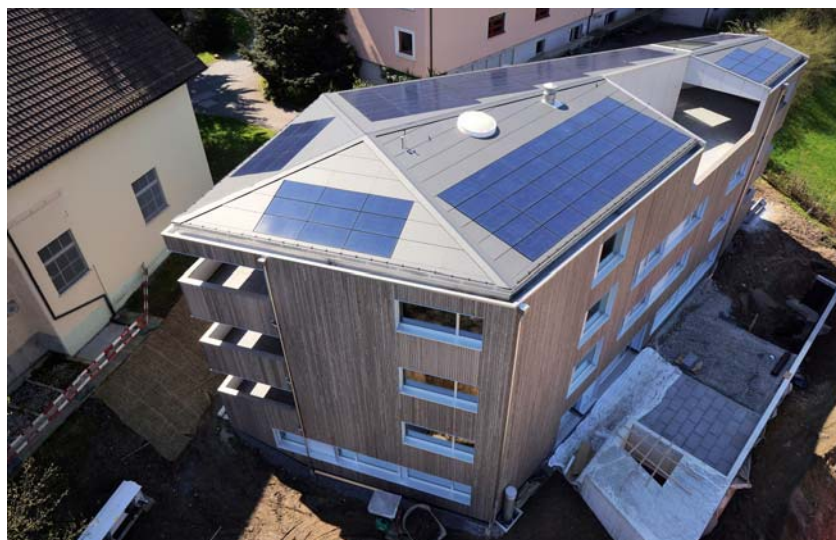
Auf dem Dach befindet sich eine integrierte 30-kW-Photovoltaikanlage, die jährlich rund 23 000 kWh Strom liefert. Die fünfeckige Form des Gebäudes ist nicht nur architektonisch interessant, sondern erlaubt auch eine hohe Tageslichtnutzung und eine aussergewöhnliche Rundumsicht.
