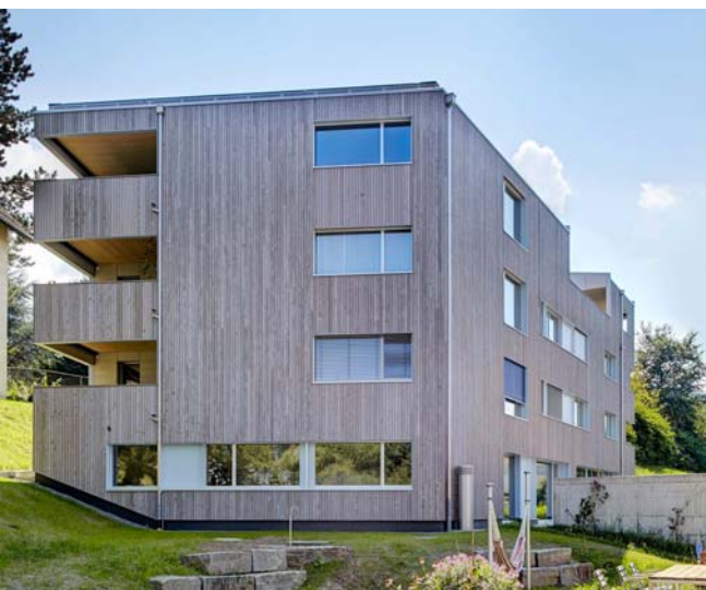
Die Bauherrschaft Marie-Theres und Markus Portmann hat im luzernischen Kriens das erste Minergie-A-ECO-MFH der Zentralschweiz realisiert. (Fotos: Gabriel Ammon/Aura)
