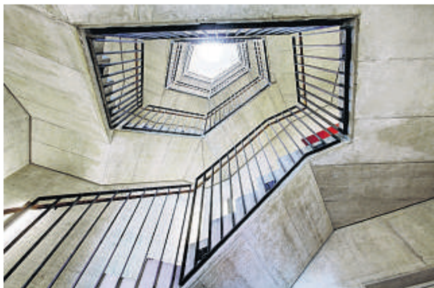
Mit einem Minimum an grauer Energie realisiert: Treppenhaus im Neubau.
