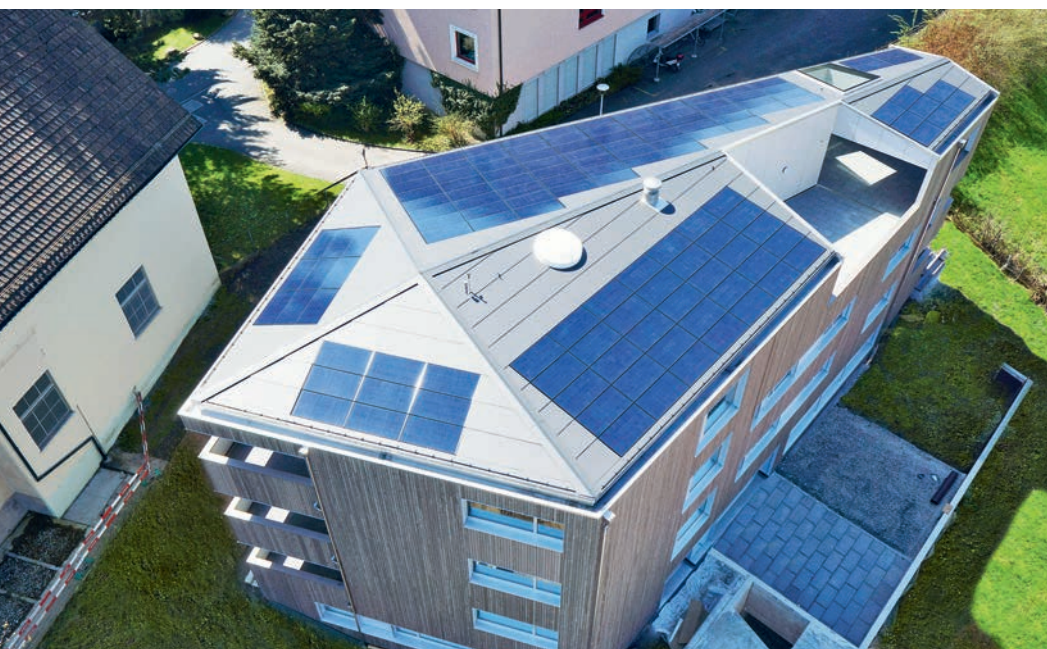
Das leicht geneigte Walmdach mit integrierter Photovoltaik. Foto: © Emanuel Ammon, Fotoagentur AURA
