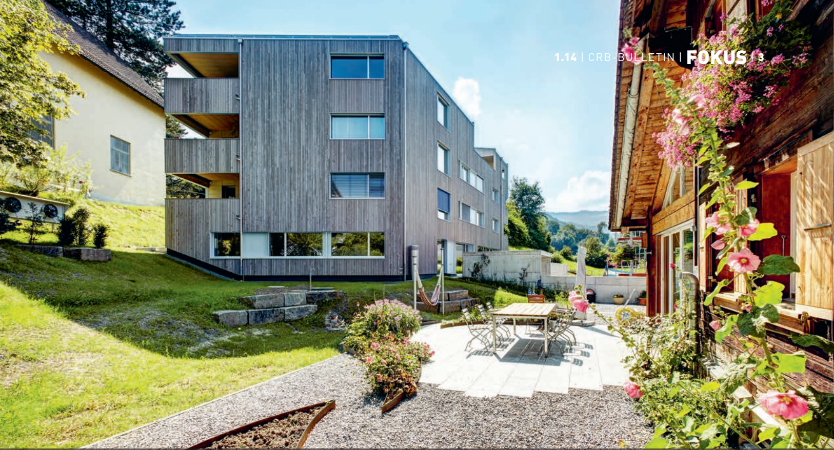
Das Mehrfamilienhaus am Kirchrainweg in Kriens erfüllt die Kriterien der Materialökologie und Energieeffizienz, berücksichtigt die regionale Wirtschaft und bietet einen hohen Wohn- und Arbeitskomfort. Foto: © Emanuel Ammon, Fotoagentur AURA
